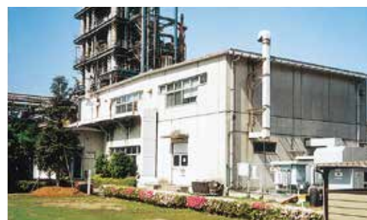
千葉工場中央制御室 Central Control Room at Chiba Works
