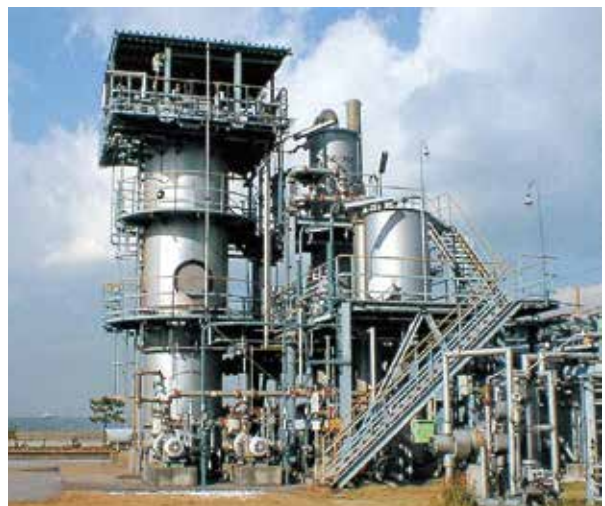
千葉工場焼却設備 Chiba Works incinerator
