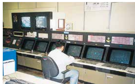
最新設備によるオペレーション Automated operation with advanced facilities
